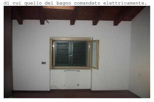
Il riscaldamento, di tipo autonomo, viene generato da caldaia murale posta nel ripostiglio e irradiato nell'appartamento tramite radiatori di metallo verniciati, il tutto comandato e controllato d'apposita centralina posta a parete.
